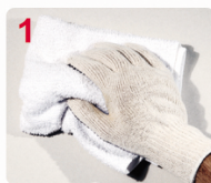
1 LIMPE A SUPERFÍCIE A SER PINTADA
