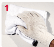
1 LIMPE A SUPERFÍCIE A SER PINTADA
