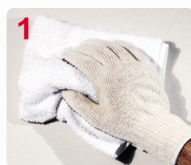
1 LIMPE A SUPERFÍCIE A SER PINTADA
