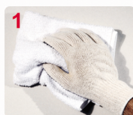
1 LIMPE A SUPERFÍCIE A SER PINTADA
