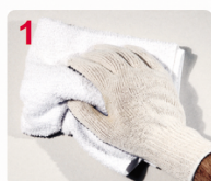
1 LIMPE A SUPERFÍCIE A SER PINTADA
