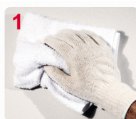
1 LIMPE A SUPERFÍCIE A SER PINTADA
